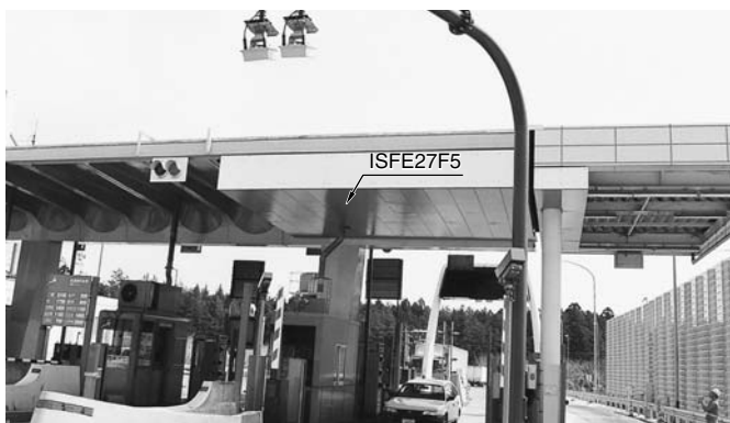
電波環境をより良い環境に整備するためにETC（自動車料金収受システム）に取り付けられたETC用電波吸収パネル例（ISFE27F5を使用）
