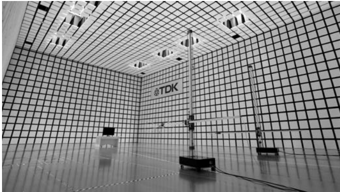
10m法電波暗室（電波吸収材として、IP材を使用しています。）
