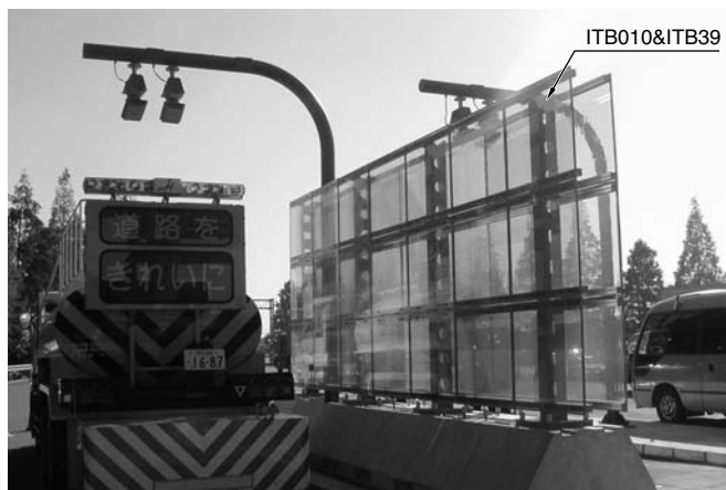
ETCのレーン間に取り付けられたETC用透明電波吸収パネル例 (ITB010とITB390使用)
